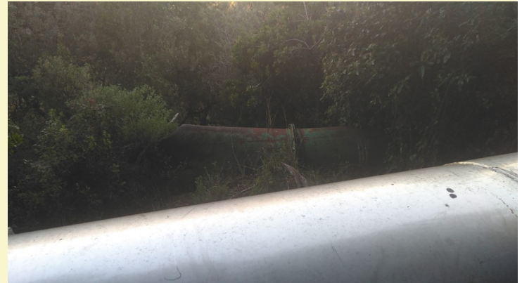
Grasse : Suez remplace les tuyaux et se débarrasse des anciens en les laissant sur place. Qu'en dit la municipalité ?
